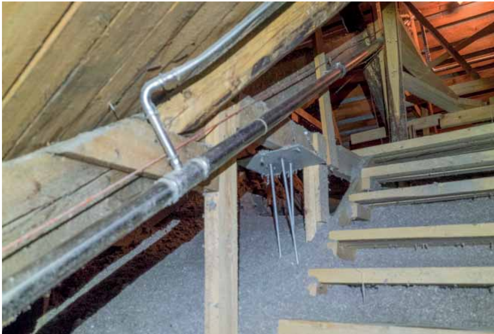
Kuvia ullakkotilasta: vasemmalla yllä eteläpäädyn luonnonkivimuuria ja kattora-kenteita, sen alla olevassa kuvassa näkyy kirkkoon asennetun vesisumusammu-tuslaitteiston putkia. Yllä yleiskuvan ullakon ja vesikaton rakenteista. Suuri putki vasemmalla kuuluu 1980-luvulla asennettuun kiertoilmajärjestelmään.
