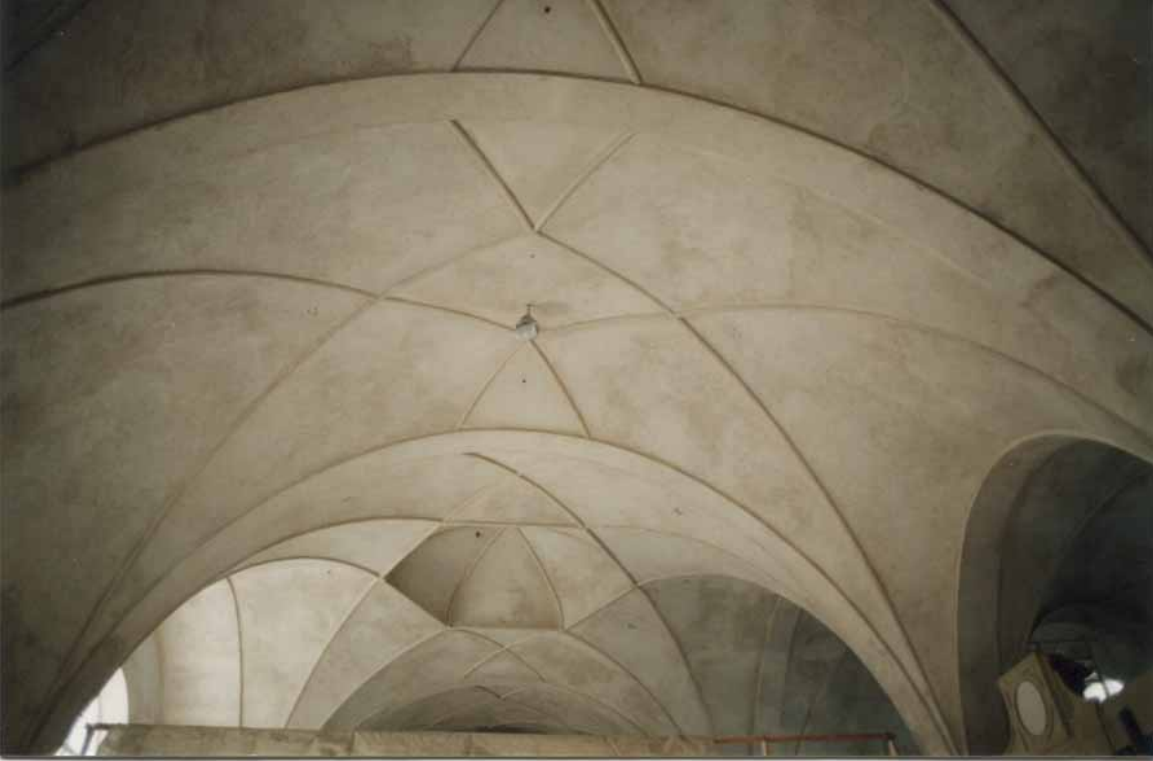
Kirkkosalin holvit rakenteiden kunnostuksen ja uudelleenrappauksen jälkeen. Yllä oikealla työmaakokouksen porukkaa pölyisessä kirkossa.
