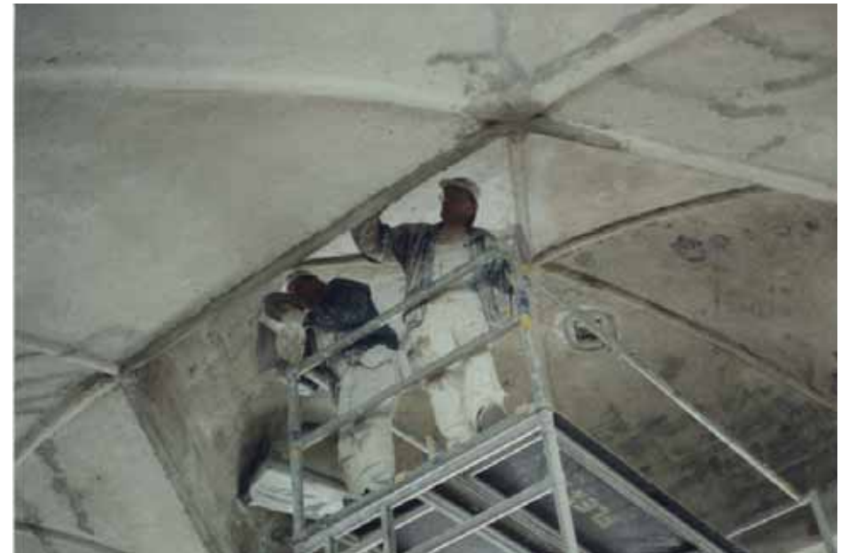
Keskiholvin kuvun rappauspaikkaukset meneillään, kun 1960-luvun korjauksessa kupuun asennettu ritilä on poistettu.
