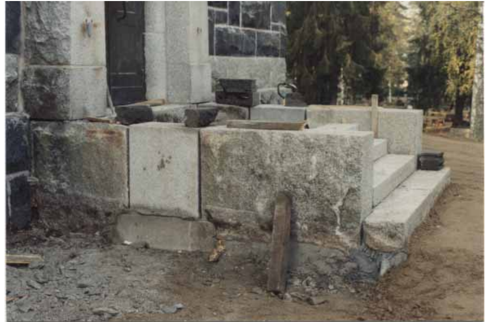
Pääsisäänkäynnin kiviporrasta levitettiin ulospäin. Portaan ylätasanne saatiin näin täyttämään pyörätuolikäytön vaatimukset. Metallirakenteinen ramppi on tässä vielä rakentamatta.
