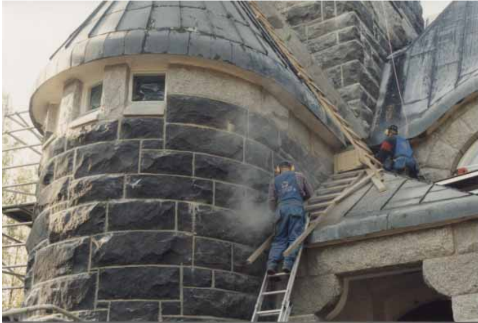
Porrashuoneen ja tornin sivuilla korotettiin peltikatteen seinäenostoja estämään veden imeytymistä seinärakenteisiin. Kuvassa on meneillään urien jyrskintä kiviin pellityksen yläreunan upotusta varten.
